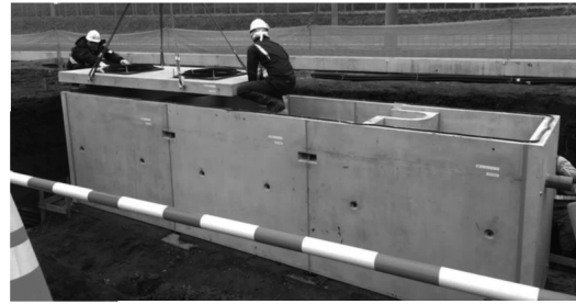
施工中のアクシスAQ
