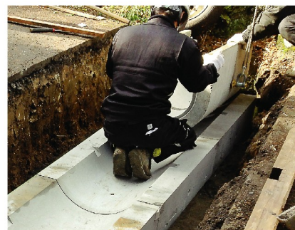
③ 側溝据え付け
