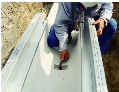
④ 固定ボルト締め
