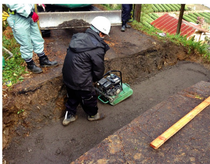
① 基礎材敷設
