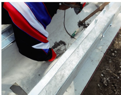
⑤ 連結部モルタル詰め
